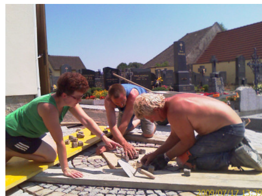
Gabriele Goldnagl, Walter Dum und Johann Dänzinger beim Verlegen des Granitpflasters.
