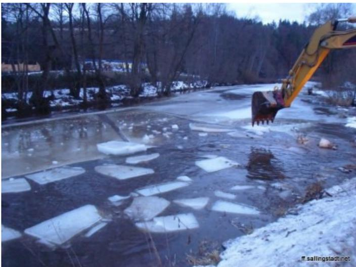
Der Bagger bricht an den für ihn zugänglichen Stellen die Eisschicht
