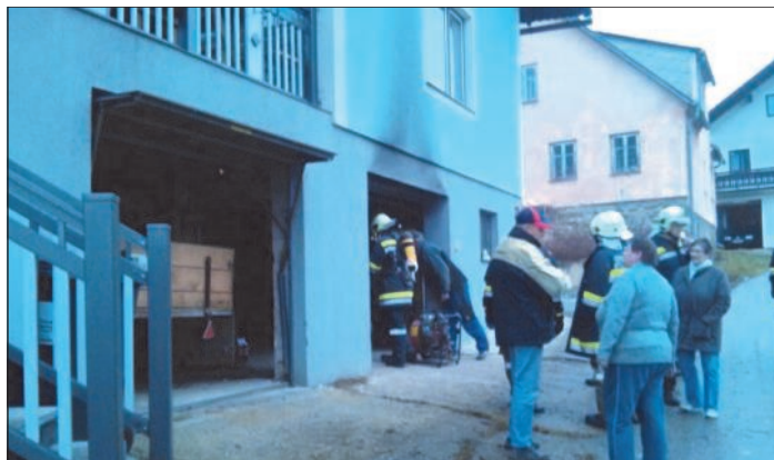
Die Spuren des Brandes waren nicht zu übersehen.
