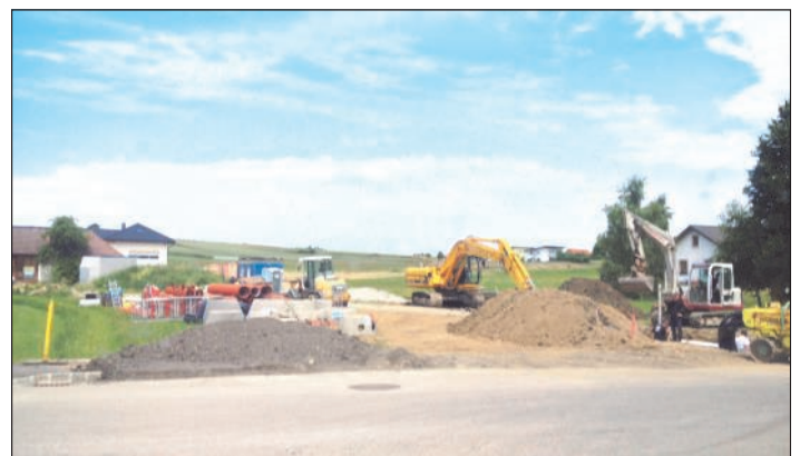
Die Bauarbeiten am neuem Bauland.
