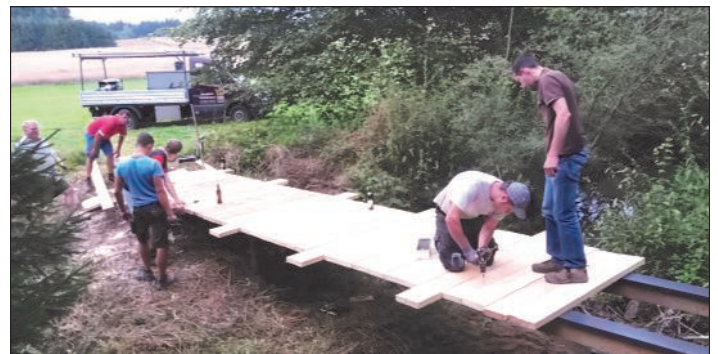
Beim Bau der Brücke wurde fleißig zusammengeworfen.
