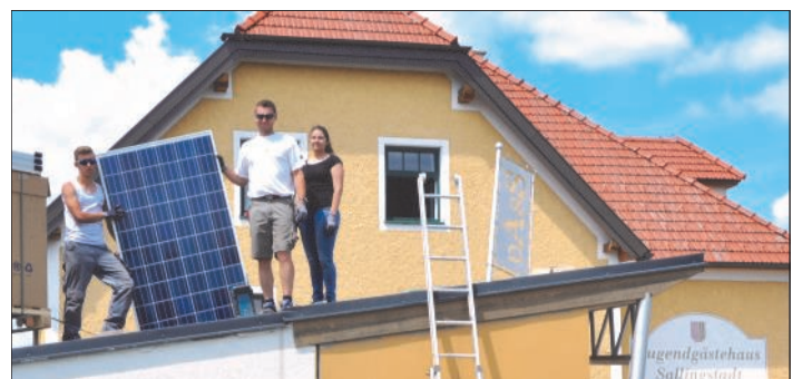
Die Mitarbeiter der Fa. Elektro Rauch: Bernd Hipp, Andreas Holzmüller und eine Praktikantin bei der Errichtung der neuen Anlage.
