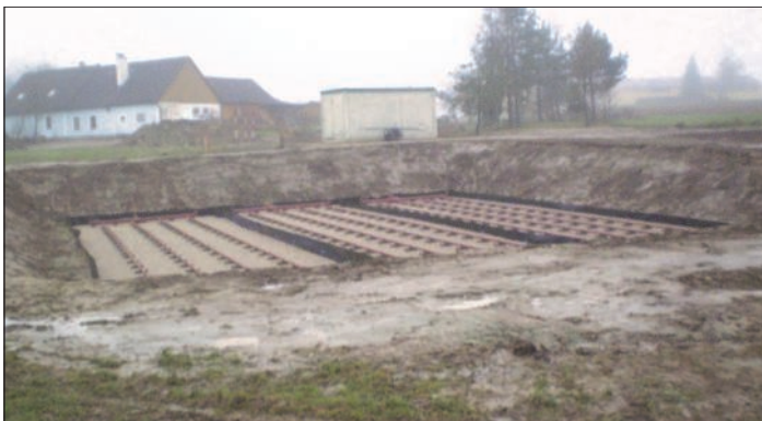
Die Baustelle im Ortsgebiet von Windhof
