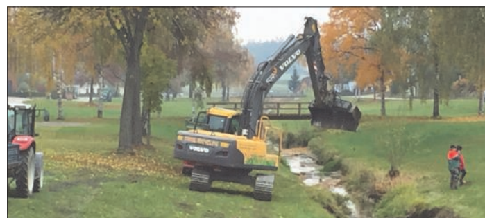
Baggerarbeiten entlang der Thaya im Ortsgebiet.
