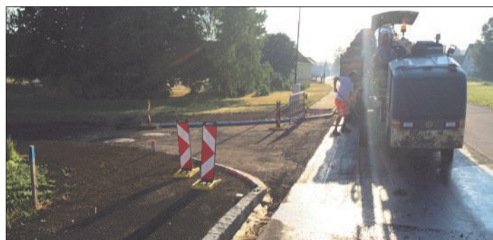
Asphaltierungsarbeiten an der neuen Siedlungszufahrt.
