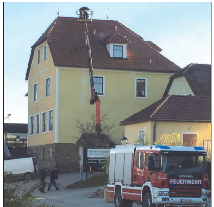
Montagearbeiten in großer Höhe.
