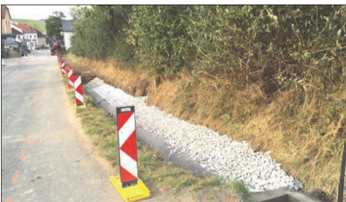
Dieser Graben wurde verrohrt.
