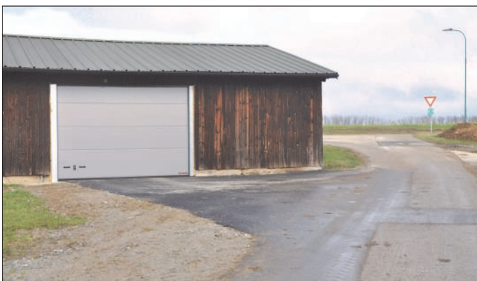
Zufahrt zur alten Sortierhalle wurde ebenfalls neu asphaltiert, sowie wurde von der Feuerwehr ein neues Garagentor eingebaut.
