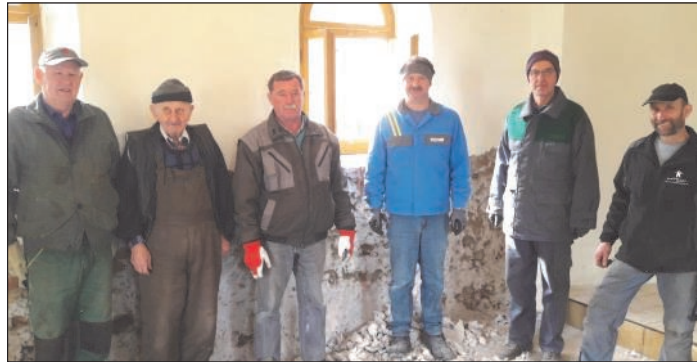
Die ersten Arbeiten: Ausräumen und alten Putz abschlagen. Walter Liebenauer, Engelbert Klenn, Franz Danzinger, Gerhard und Franz Klenn sowie Mesner Walter Gretz
