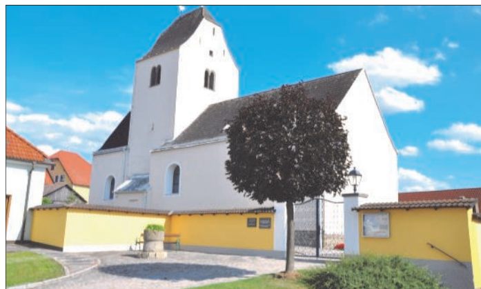
Die Friedhofsmauer wurde im Eingangsbereich saniert
