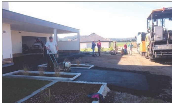
Die Arbeiten bei der neuen Siedlung „Sommerseith“
