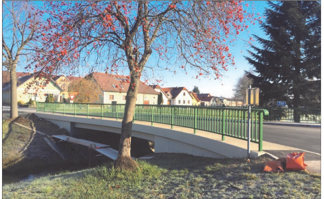
Die große Straßenbrücke in der Dorfmitte wurde generalsaniert.
