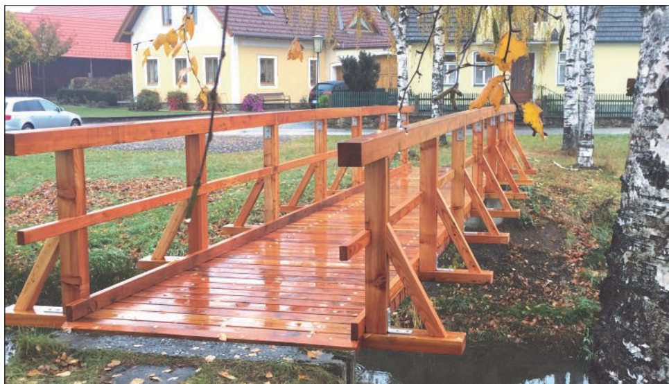
Der neu sanierte Thayasteg.
