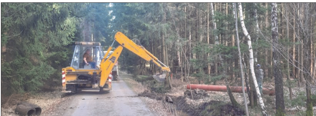
Harald Zauner wurde seitens der Gemeinde beauftragt, bei der Entwässerung mit seinem Bagger mitzuhelfen.
