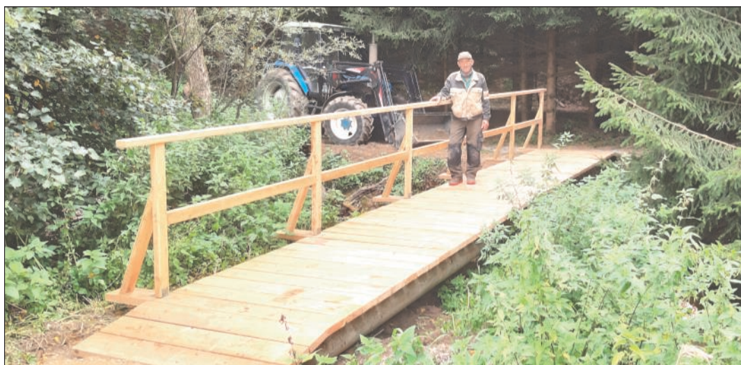
Die vollständig erneuerte Thayabrücke beim familien.weg mit Walter Gretz
